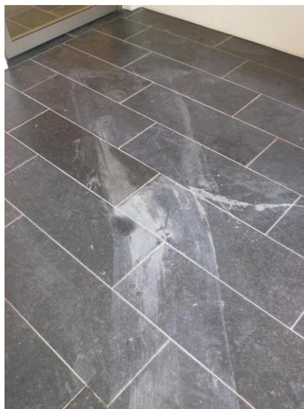
Flusssäurerückstände auf Boden und mit Besen verteilt
